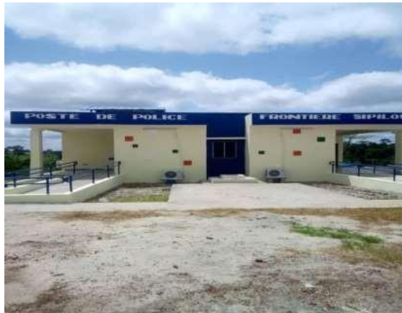
Poste de police frontalier de Sipilou réhabilité
