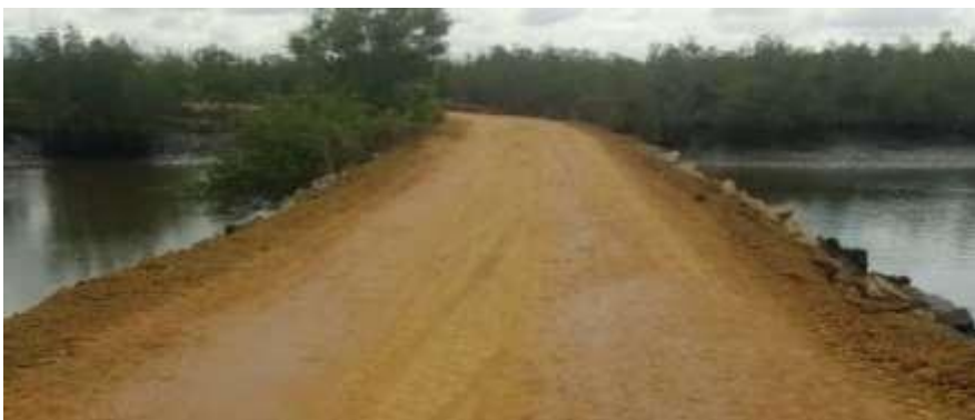
REHABILITATION DE LA PISTE KOURAI- DIAFLADOU-WORO (5,800) km A BEYLA
