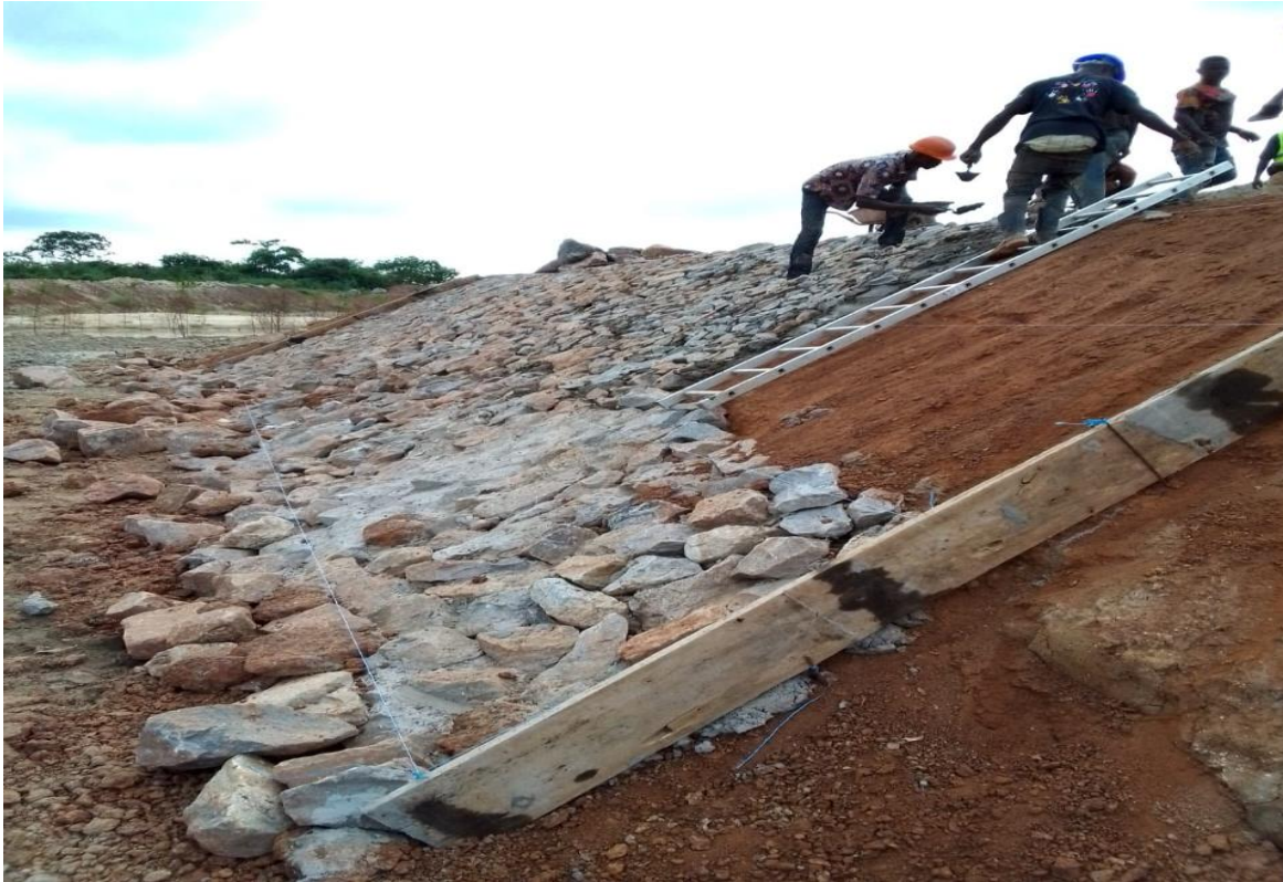
Enrochement du chenal dans le projet de construction du barrage de Raviart et d'aménagement de 125 hectares de périmètre
