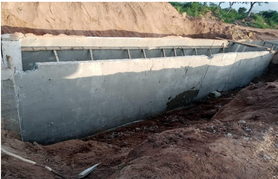
Coffrage et coulage du déversoir dans le projet de construction du barrage de Raviart et d' aménagement de 125 hectares de périmètre
