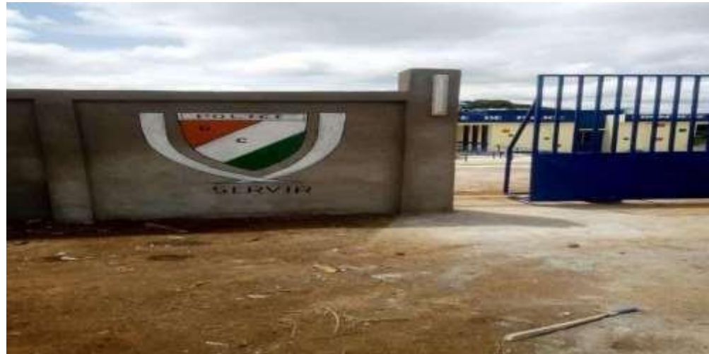
Façade du poste frontalier de Sipilou
