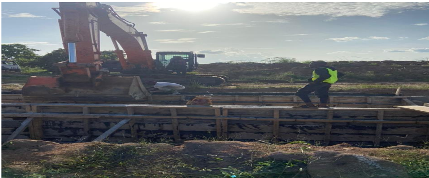
Coffrage et coulage du déversoir dans le projet de construction du barrage de Raviart et d' aménagement de 125 hectares de périmètre
