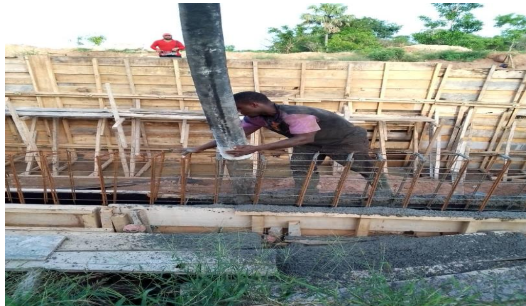
Coffrage et coulage du déversoir dans le projet de construction du barrage de Raviart et d' aménagement de 125 hectares de périmètre
