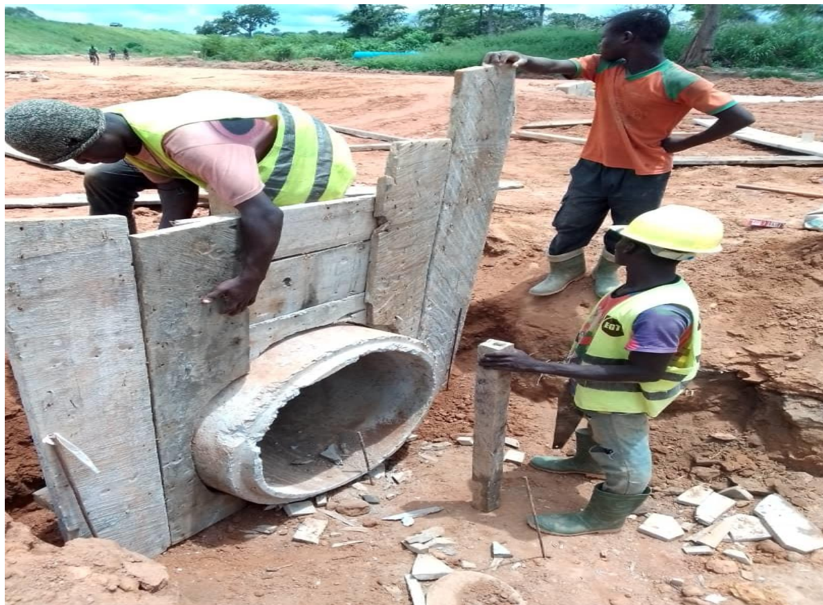
Pose de buse, coffrage pour raccordement de canaux dans le projet de construction du barrage de Raviart et d' aménagement de 125 hectares de périmètre
